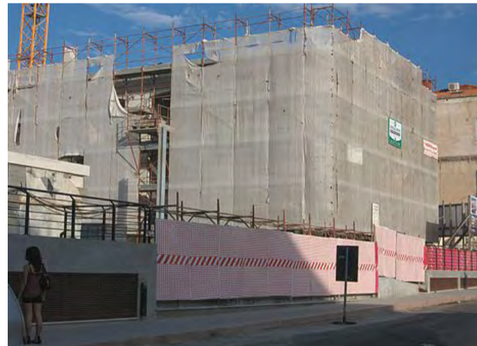
Il cantiere di piazza Dei Mercati
