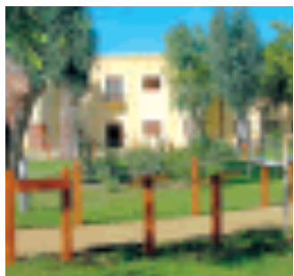
La sede del Parco di Porto Conte
